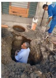
Com uma ligação antiga e vazamentos, a rede de tubulação de esgoto da Rua Hermenegildo de Barros, em frente ao número 24, em Santa Tereza, foi trocada por solicitação do **Vereador Carlo Caiado**. A obra durou três dias, devido às escavações e os canos foram substituídos por outros mais modernos. A calçada por onde passa parte da rede de esgoto também foi totalmente refeita.
