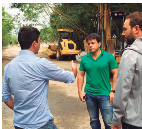
Prefeitura realiza obras para a concessão de licenças da Via 4
