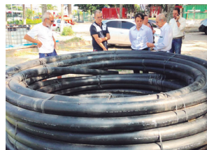
Caiado acompanha a chegada das tubulações na Gigóia
